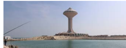
٢- برج مياه الخبر
