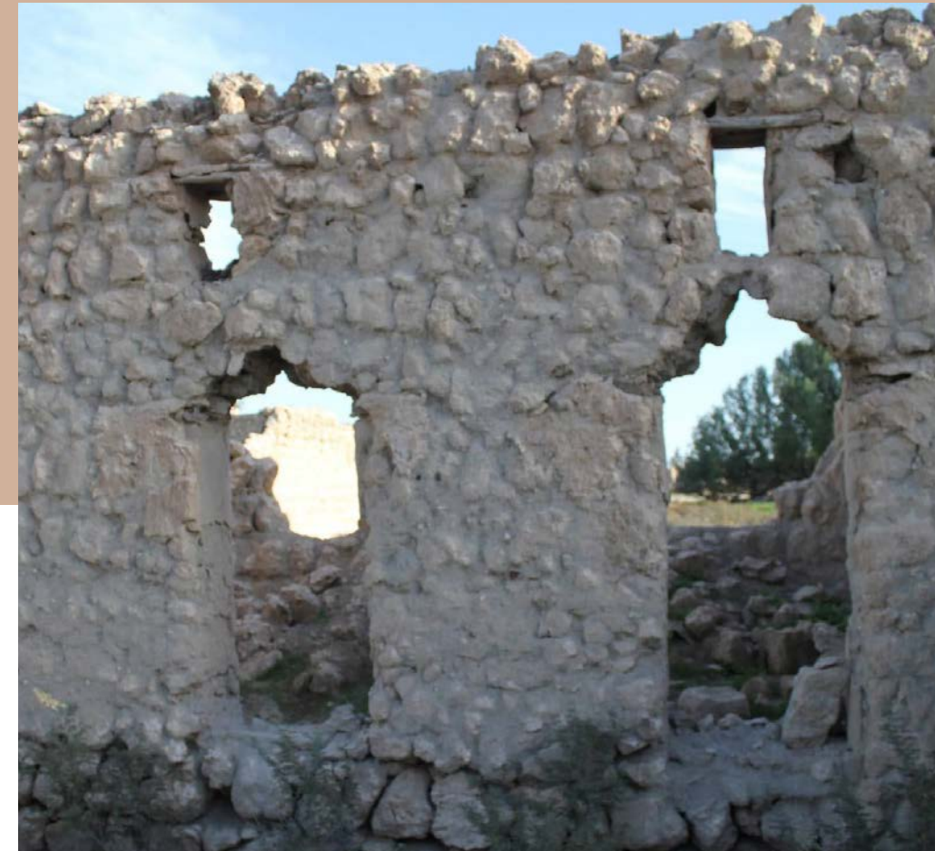
جدران طينية مبنية باستخدام "طريقة المداميك".
